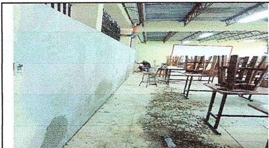
Foto 1: Eliminación de la pared dañada por la humedad para su recuperación y tratamiento.
