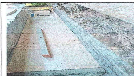
Foto 4: Colocación de azulejo en los canales de conducción del agua captada por el techo, para evitar su infiltración.
