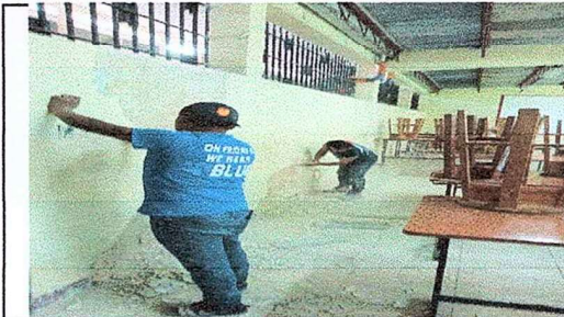
Foto 2: Recuperación de paredes dañadas por la humedad para su tratamiento y pintura.
