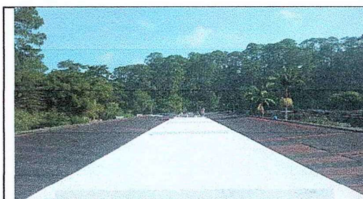
Foto 5: Aplicación externa del Impermeabilizante en la losa, en un espacio de más de 100 metros lineales.
