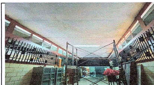
Foto 3: Trabajos para la recuperación de la losa de laboratorios y talleres Industriales.
